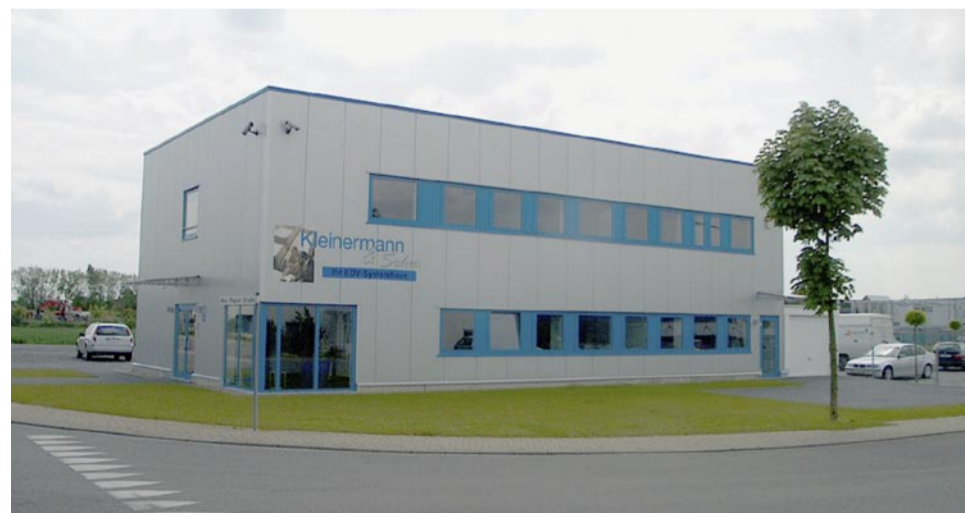
Die Zentrale des bundesweiten Netzwerks in Baesweiler
